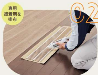
両面テープの間に専用接着剤を塗布します
