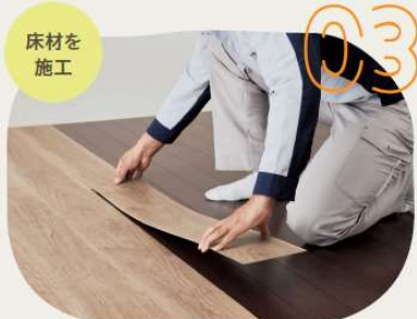
裏面のはく離紙をはがして床材を施工します
