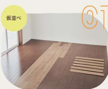
仮並べをして外観確認後、墨打ちします
