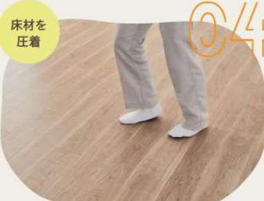
上から踏み込んでテープと床材を圧着します
